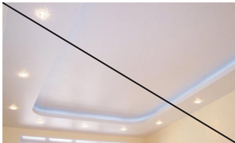
Плохо Многоуровневые гипсокартонные конструкции
